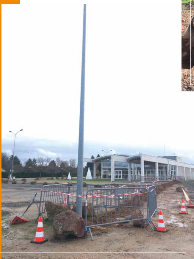
Travaux d'éclairage public
