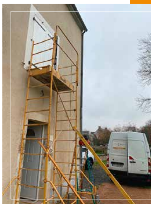
Changement des menuiseries au gîte
