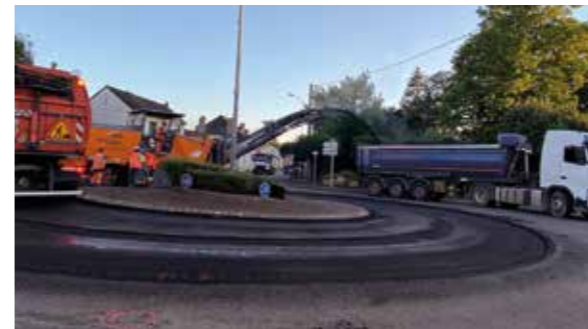
Réfection de la RD 951 route de Culan réalisée les 27 et 28 juin 2022
