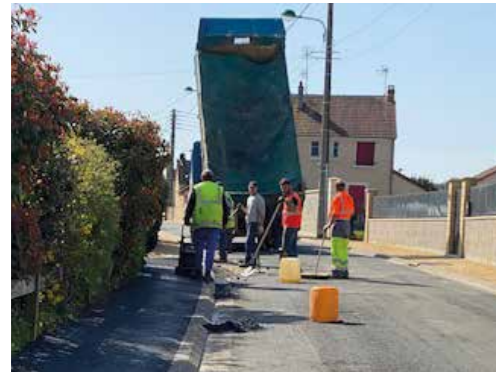
trottoirs en enrobé rue du Reuilly (entreprise Laumonnier) 22 mars 2022
