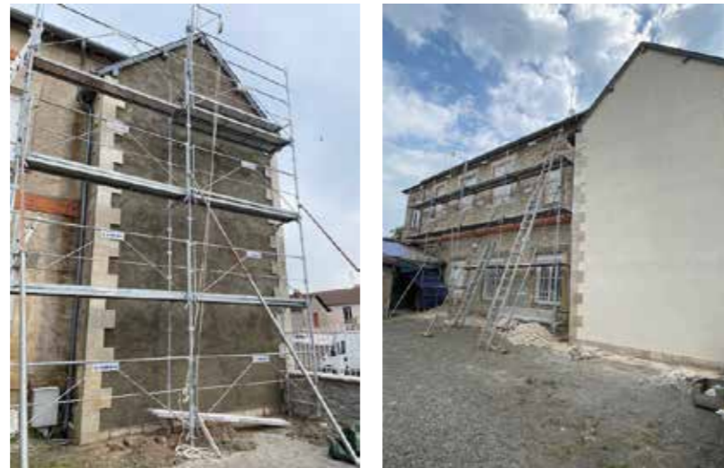
À la mairie, travaux confiés à l'entreprise Saccas
