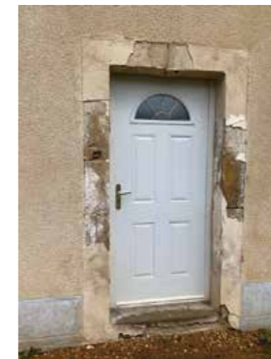
Encadrement de la porte au gîte avant réfection
