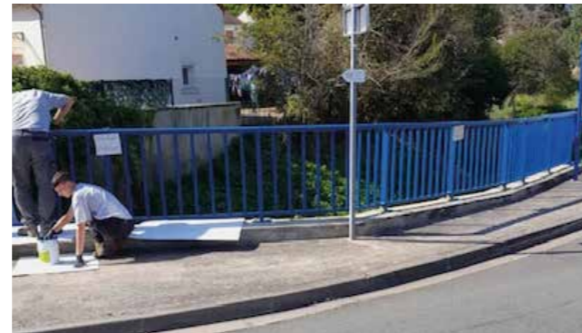
Peinture de la barrière à l'intersection route de Culan et route de Lignièrès
