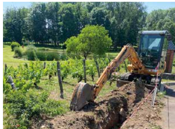
Réalisation en régie d'une tranchée pour câblage de la borne électrique foraine. Parc de la loge des vignes Juin 2022
