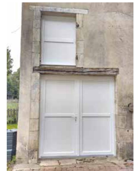
Nouvelles portes de la grange au gîte (entreprise Dumay)
