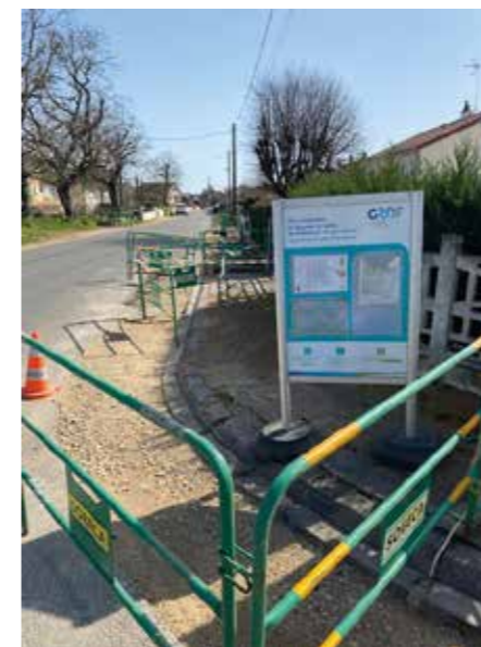
Rénovation des canalisations de gaz rue des Violettes, rue des Fougères 22 mars 2022
