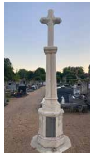
Croix à l'ancien cimetière réparée par l'entreprise Imbault en juin 2022
