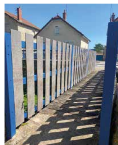
Rénovation de la passerelle reliant la route de Lignièrès au parc de la Loubière - Fournitures JPB
