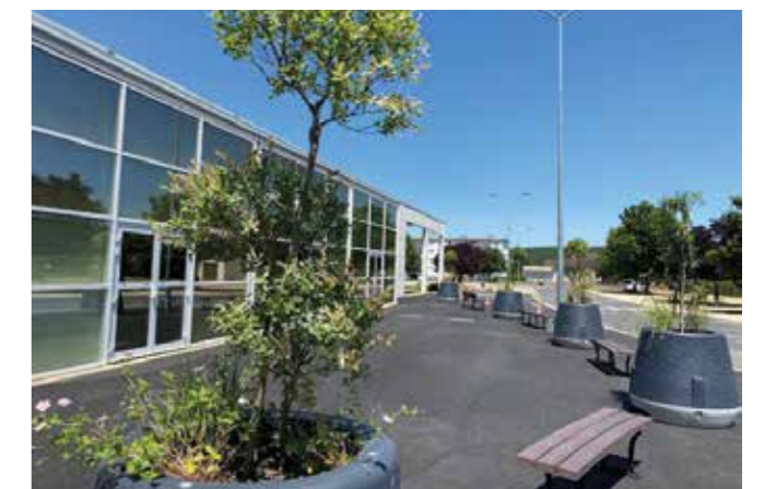
Dans le cadre de vigipirat, sécurisation des baies vitrées du CSC (installation juin)
